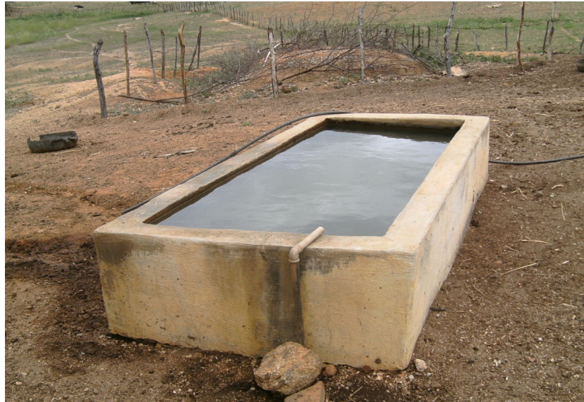
Foto 13 – Tanque de alvenaria.
