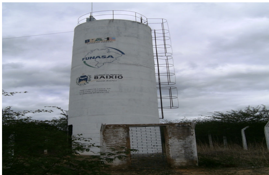
Foto 9 – Caixa que disponibiliza água canalizada.
