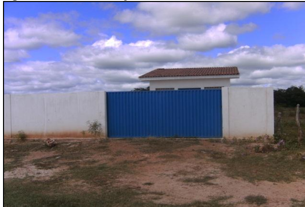
Fotografia XIII - Estação Elevatória II (Área Externa)
