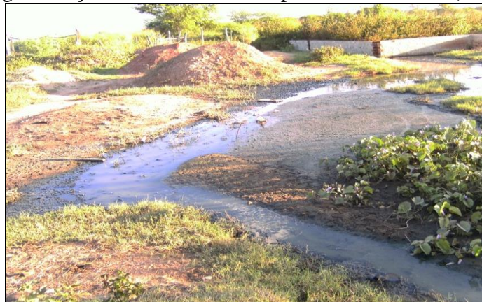
Fotografia IX - Esgoto lançado diretamente na superfície do terreno (Bairro das Populares)
