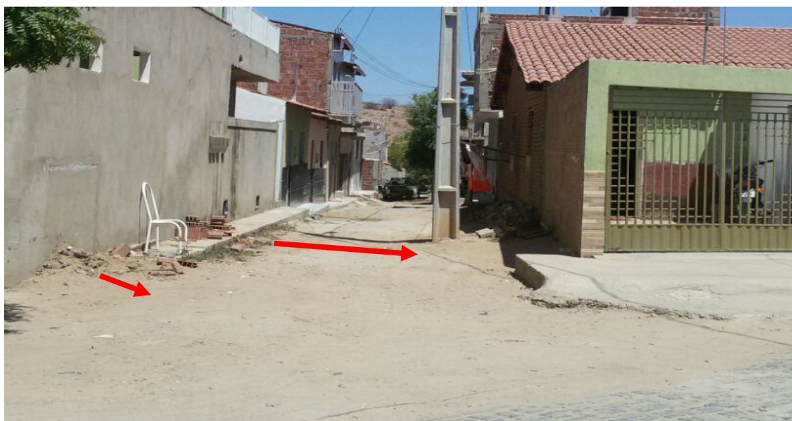
Fotografia 15 -Estreitamento das vias e passeios públicos
