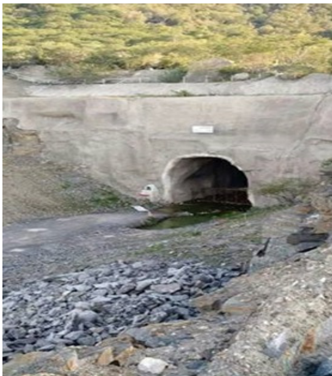
Fotografia 4 - Túnel de Cuncas II
