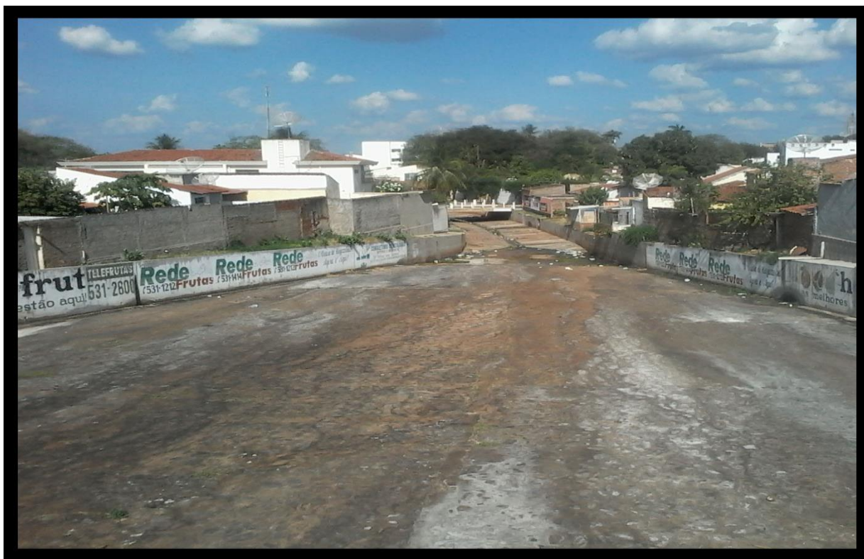
FOTO 02 - Sangradouro do Açude Grande (Foto recente)
