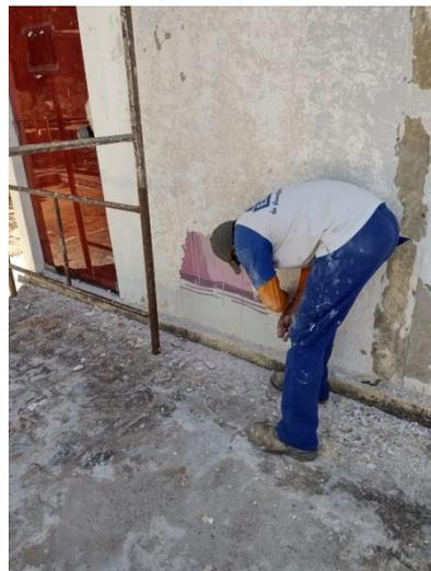
Raspagem da camada de tinta solta do Bloco de Informática.
