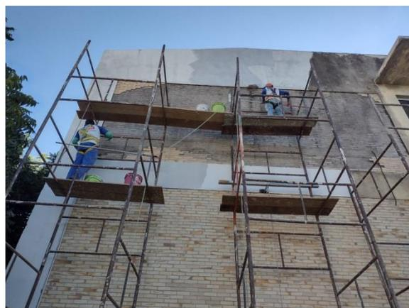
Pintura com tinta látex acrílica na fachada do bloco de Laboratório de Práticas Medicina.
