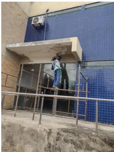
Raspagem da camada de tinta solta na marquise da fachada do Bloco Laboratório de Práticas Medicina.
