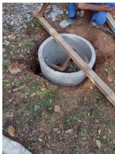
Instalação de caixa de passagem na rede de água fria – CA1.
