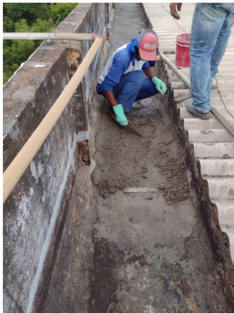
Impermeabilização da calha do CA1 com argamassa de cimento e areia com aditivo impermeabilizante.
