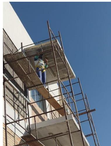
Raspagem da camada de tinta solta e aplicação de selador na fachada do bloco de Laboratório de Práticas Medicina.
