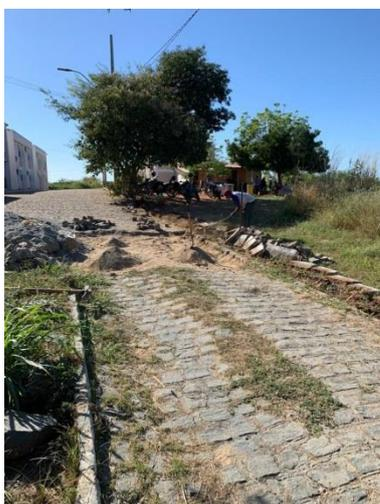
Demolição de pavimento, com reaproveitamento de pedras.
