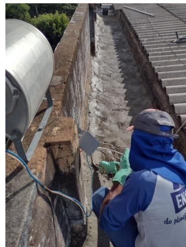
Impermeabilização das calhas com argamassa de cimento e areia com aditivo impermeabilizante.
