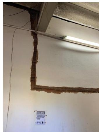
Rasgo em alvenaria para passagem de pontos de água fria – WC Feminino do Central Acadêmico.
