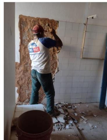
Demolição de revestimento cerâmico de forma manual – WC Masculino do Central de Aulas.
