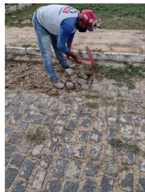
Demolição de pavimento com reaproveitamento de paralelepípedos.
