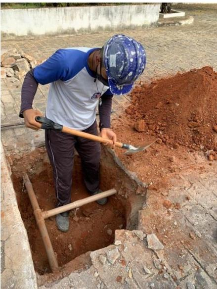
Demolição de pavimento e escavação de vala para instalação de caixa de passagem – CA2.
