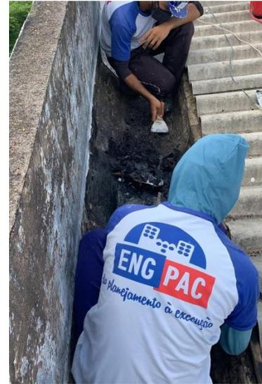
Remoção de manta asfáltica e limpeza de calha – CA1.
