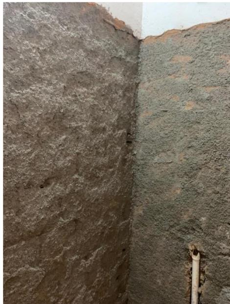
Aplicação de chapisco nas paredes que irão receber revestimento cerâmico – WC Feminino do Central de Aulas.
