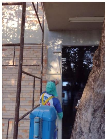
Aplicação de massa acrílica e selador na fachada do bloco de Laboratório de Práticas Medicina.
