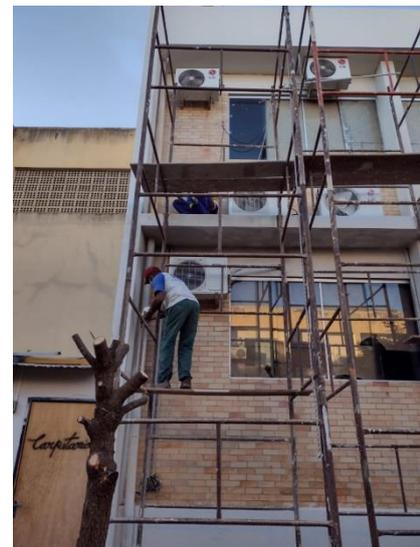
Pintura com tinta látex acrílica na fachada do bloco de Laboratório de Práticas Medicina.
