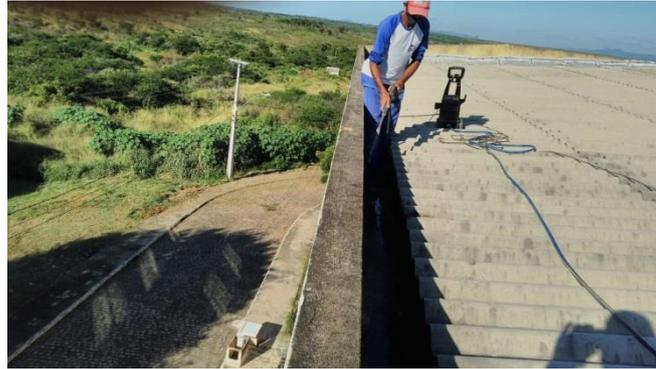
Lavagem das calhas com jato para aplicação de impermeabilizante.
