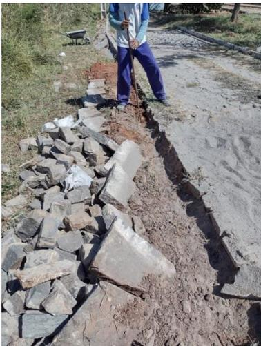
Remoção de meio fio, com reaproveitamento de pedras.
