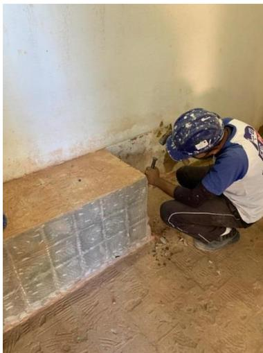
Demolição de alvenaria em bloco furado de forma manual – WC Feminino do Central Acadêmico.
