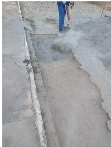
Demolição de pavimento com reaproveitamento de paralelepípedos – Por trás do Refeitório.
