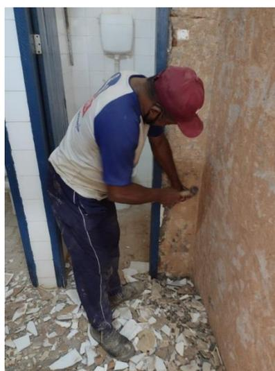
Demolição de revestimento cerâmico de forma manual – WC Feminino do Central de Aulas.
