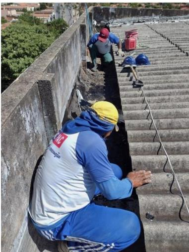
Remoção de manta asfáltica – Calha do CA1.
