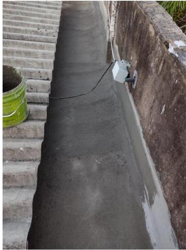
Impermeabilização de superfície com revestimento bicomponente semiflexível 3 demãos –
