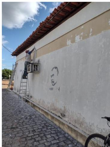
Lixamento e aplicação de selador na fachada do Bloco de Informática.
