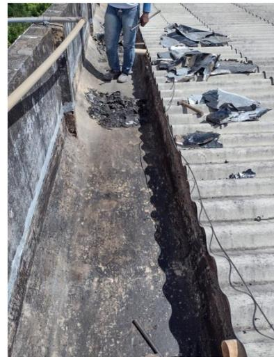
Remoção de manta asfáltica e limpeza de calha – CA1.
