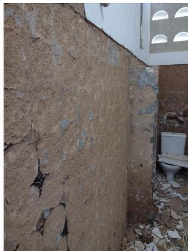
Demolição de revestimento cerâmico de forma manual – WC Masculino do Central de Aulas.
