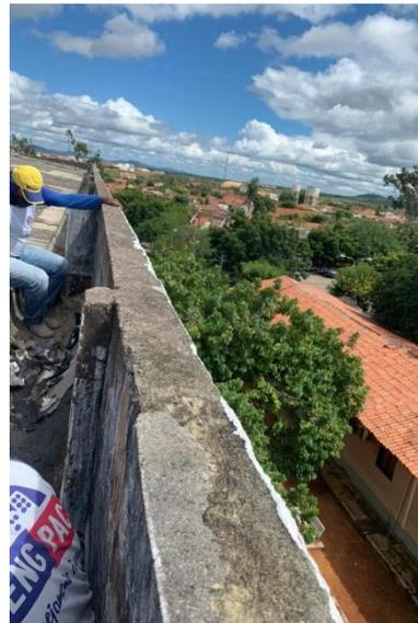
Remoção de manta asfáltica e limpeza das calhas do CA1.
