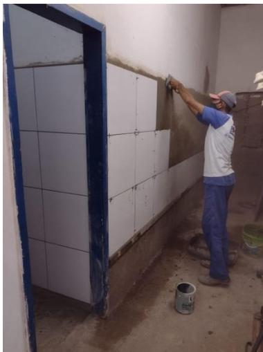
Aplicação de revestimento cerâmico nas paredes do banheiro feminino do Central Acadêmico.
