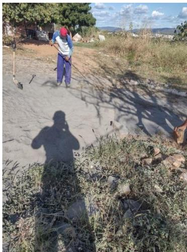
Demolição de pavimento, com reaproveitamento de pedras.
