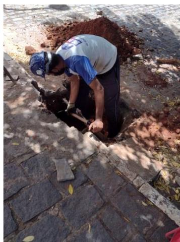
Demolição de pavimento e escavação de vala para instalação de caixa de passagem.
