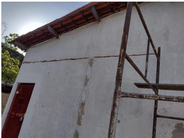
Aplicação de selador na fachada do Bloco de Informática.
