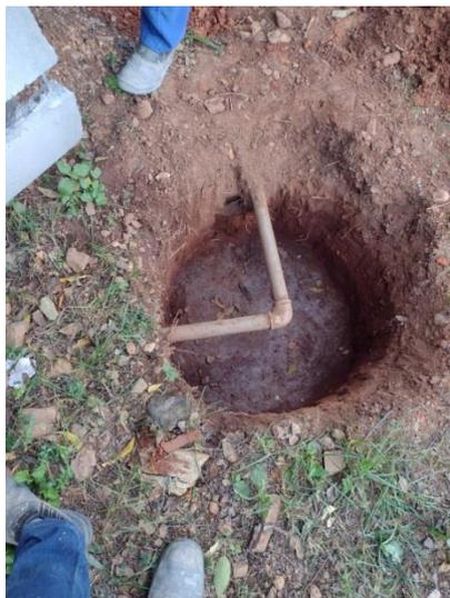
Escavação de vala para instalação de caixa de passagem - CA1.
