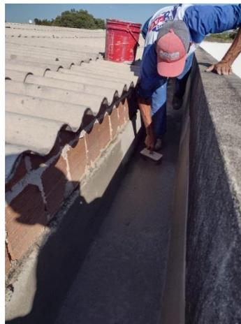
Impermeabilização da calha do bloco Laboratório de Medicina.
