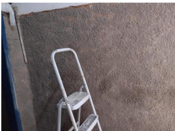
Aplicação de chapisco nas paredes que irão receber revestimento cerâmico – WC Feminino do Central de Aulas.
