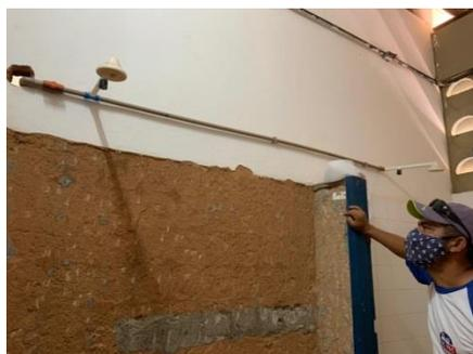
Demolição de revestimento cerâmico de forma manual – WC Feminino do Central de Aulas.
