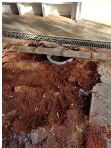
Demolição de pavimento, escavação de vala e instalação de caixa de passagem na rede de água fria – CA1.
