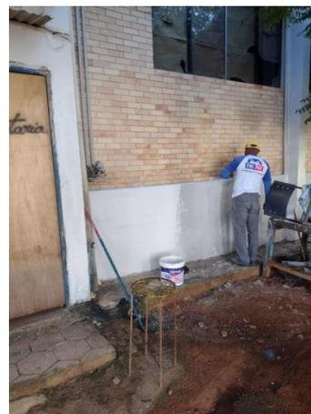
Pintura com tinta látex acrílica na fachada do bloco de Laboratório de Práticas Medicina.
