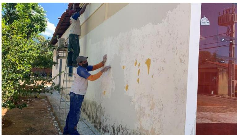
Raspagem da camada de tinta solta na fachada do Bloco de Informática.
