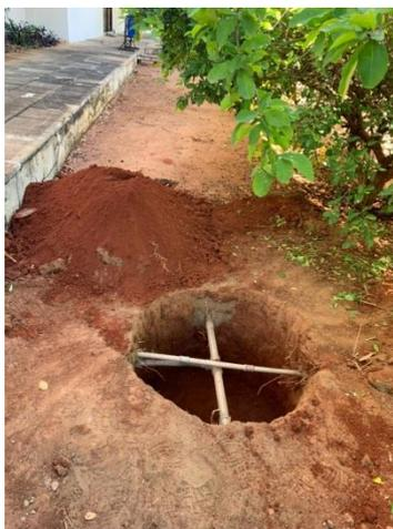
Escavação de valas para instalação de caixas de passagem.
