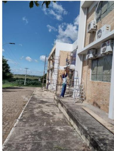
Pintura com tinta látex acrílica na fachada do Laboratório de Práticas Medicina.
