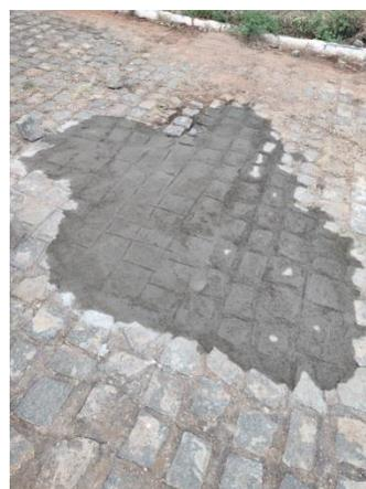
Reassentamento de paralelepípedo sobre colchão de pó de pedra rejuntado com argamassa – Por trás do refeitório e próximo ao CA2.
